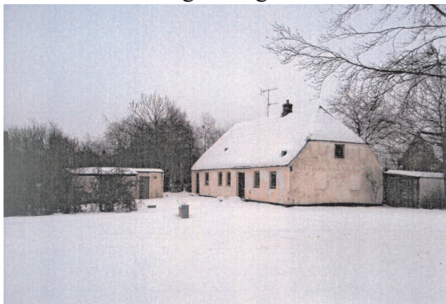
Tinggade 32. - før det faldt.
