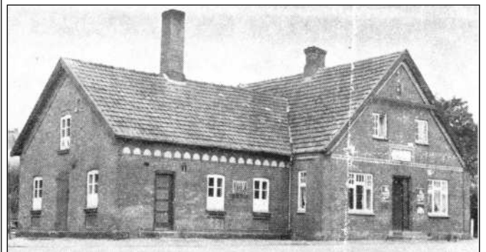
Vejrumbro Kro. I tilbygningen var der bageri, men den blev nedrevet samtidig med vejændringen, som omtales senere.
