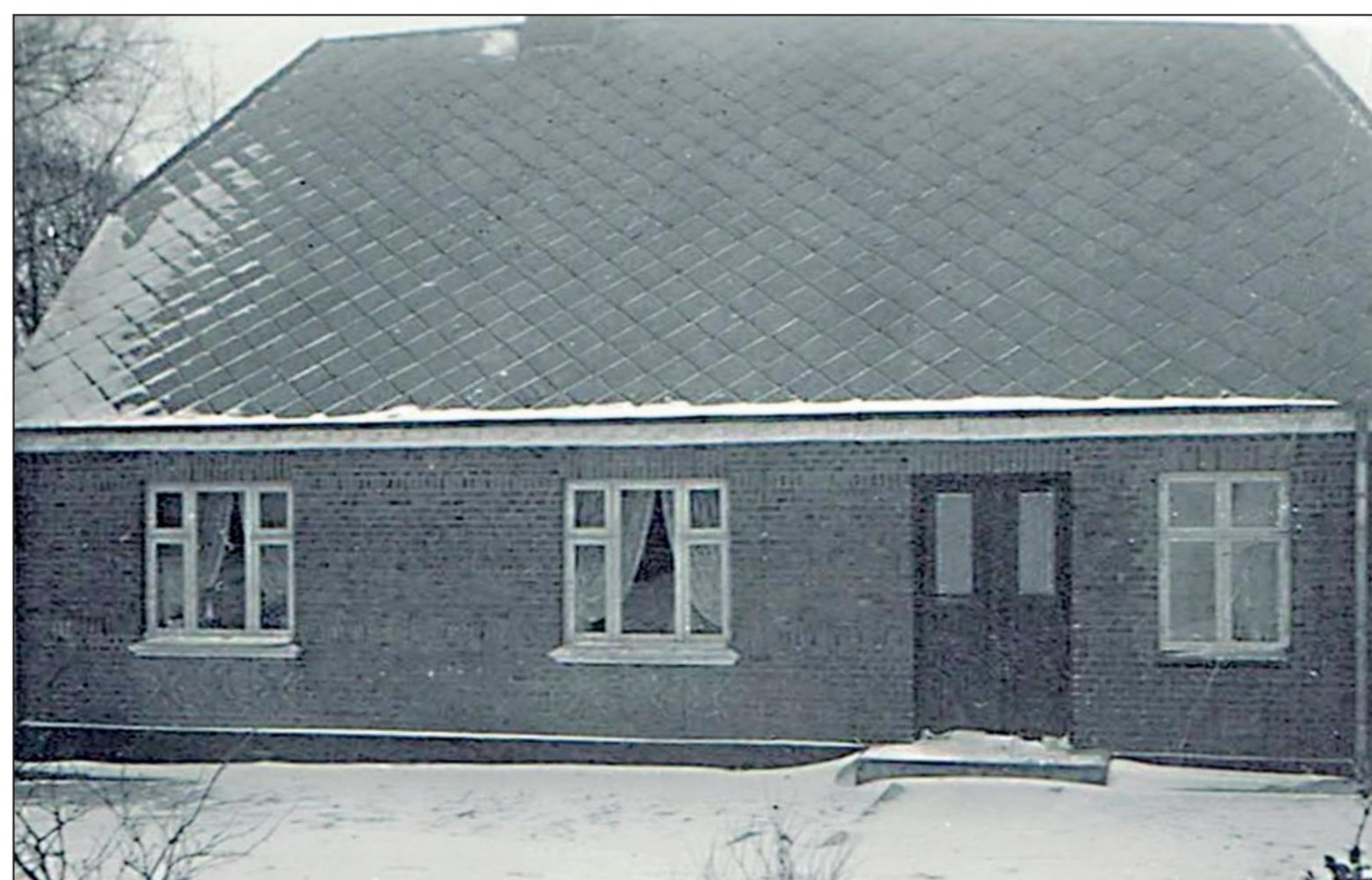
I forbindelse med, at hjemmet i Møllerup blev udstyret med toilet og rindende (koldt) vand, blev der samtidig lavet et værelse ud til vejen, hvorfor der kom endnu et vindue i facaden.
